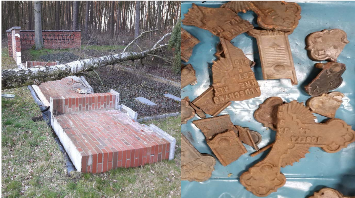
Die durch Windbruch, im Frühjahr diesen Jahres, umgestürzte Mauer mit Grabkreuzen auf dem Internierungsfriedhof in Müggenbusch (links) und rechts die vollständig zerbrochenen Grabkreuze nach der Befundung Foto: © fweDESIGN
