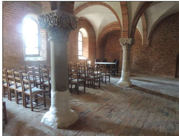
Die Säulen im sog. Sommerrefektorium, Kloster Jerichow, während der jüngsten Restaurierungsarbeiten.
