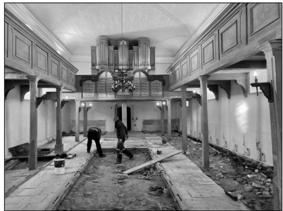
Sanierungsarbeiten im Innenraum der Boitzenburger Kirche
